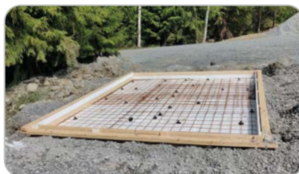
Hiekkasiilon uusi perustus valettiin huoltohallin pihaan.
