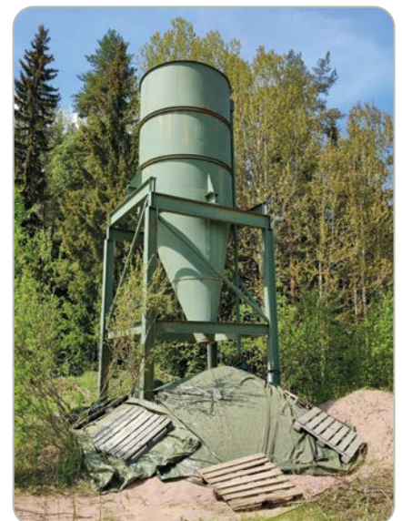
Tenniskadun varressa oleva hiekkasiilo siirretään huoltohallin pihaan.
