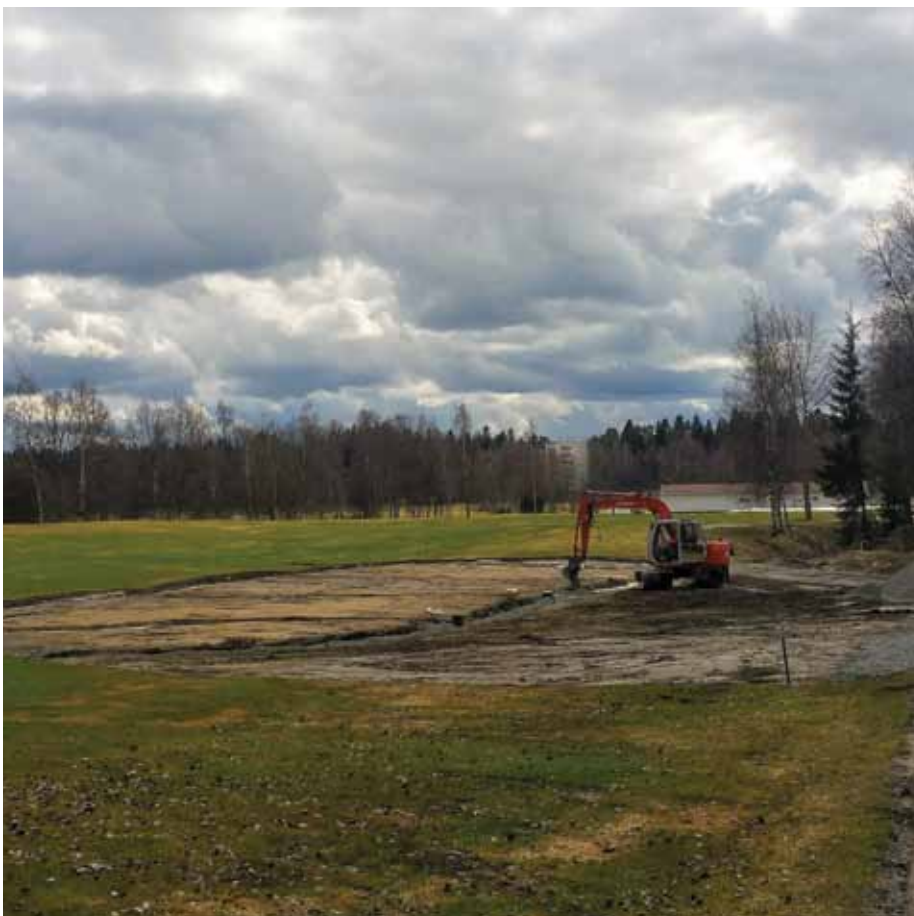
Väylän 18 niin sanottu Minetin mutka kuivatetaan salaojittamalla.
