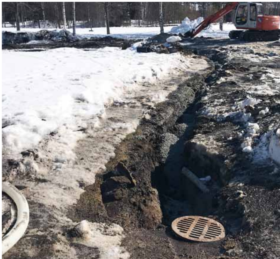
Väylän 14 viheriön edustan kuivattamiseksi kaivettiin uutta salaojaa.
