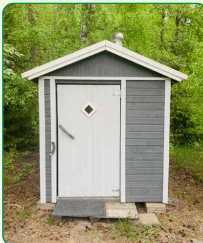
Kentän väylän 7 wc siivotaan ja huoltokorjataan kesäkuussa.
